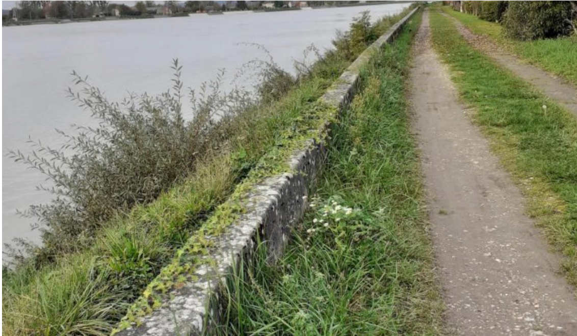
Exemple de digue
